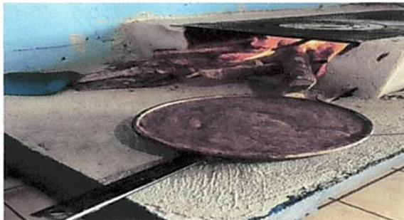
Foto1: Mejoramiento de cocina, reconstrucción de poyotón, colocación de plancha y chimenea.
