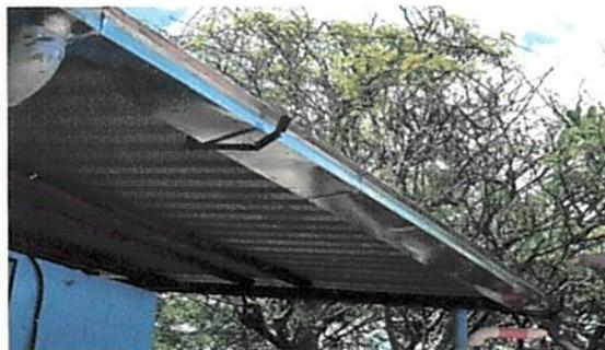
Foto 6: Reparación de canales y bajadas de agua.
